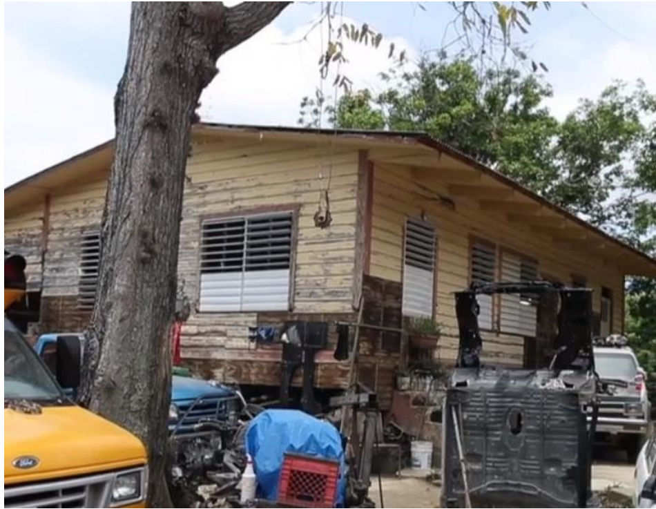
Figura 4. 23 Escuela abandonada en el pueblo de Peñuelas convertida en vivienda luego del Huracán María.
