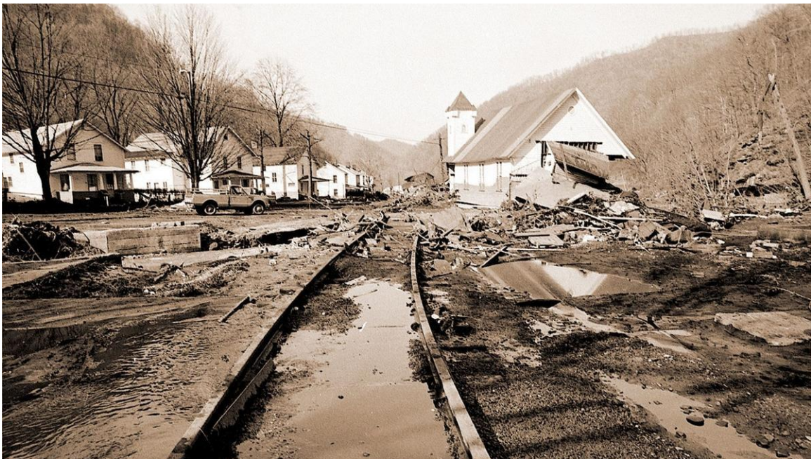
Figura 3. 1 Destrucción a lo largo de Buffalo Creek el 27 de febrero de 1972 Tomada de: https://www.herald-dispatch.com/multimedia/photo_galleries/gallery-the-buffalo-creek-flood/article_ce58fc9a-a6b1-5fc2-9845-d8ecd1c15ec5.html
