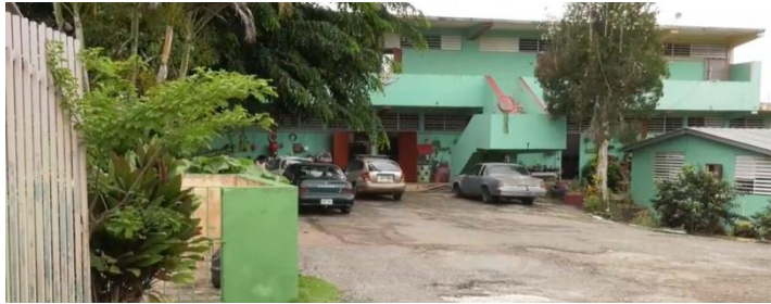
Figura 1. 2 Escuela Aquino Rivera en desuso siendo utilizada como vivienda por dos familias
