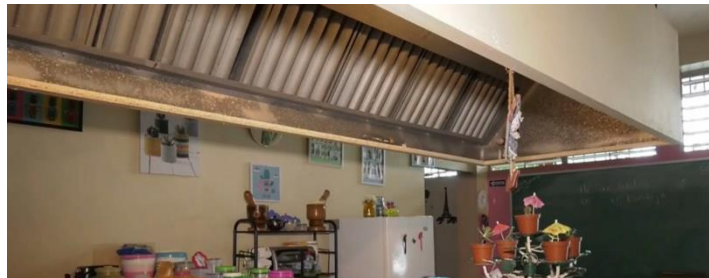
Figura 1. 4 Interior de la cocina de escuela Aquino Rivera en desuso
