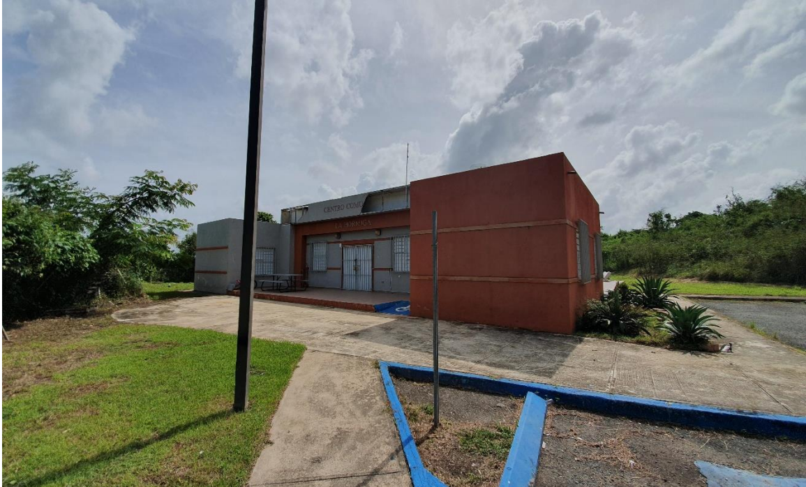
Figura 4. 14 Centro comunal del barrio La Hormiga en Juncos Puerto Rico
