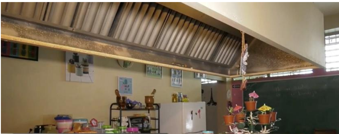
Figura 4. 20 Cocina de escuela Aquilino Rivera convertida en comedor por las familias alojadas luego del paso del Huracán María. Tomada de: https://www.telemundopr.com/noticias/puerto-rico/exclusiva-_familias-vive-en-escuela-desde-mar_a_tlmd-puerto-rico-2/104445/
