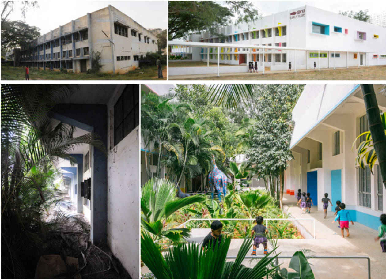
Antigua fábrica existente / condición actual
