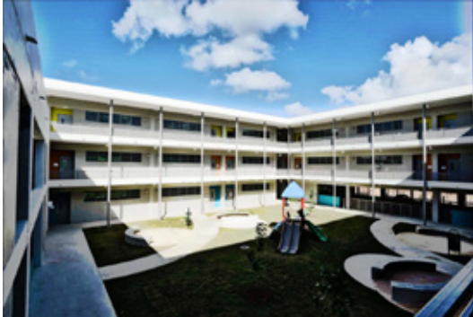
Patio interior con vegetación mínima
