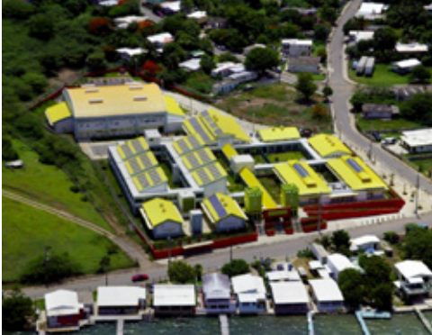
Paneles solares Algunos salones ventilación natural
