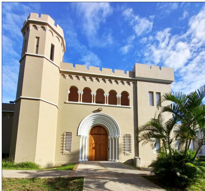
Vista frontal del edificio que alberga el Archivo Histórico.
