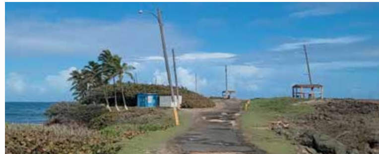
Figura 3.7 Baños/container y gazebo (2022)
