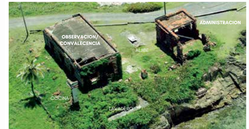
Figura 3.15 Edificios de Administración y Convalecencia, 2003, (Foto R. Ramírez Buxeda) Imagen tomada de (Schiappacasse, 2010)
