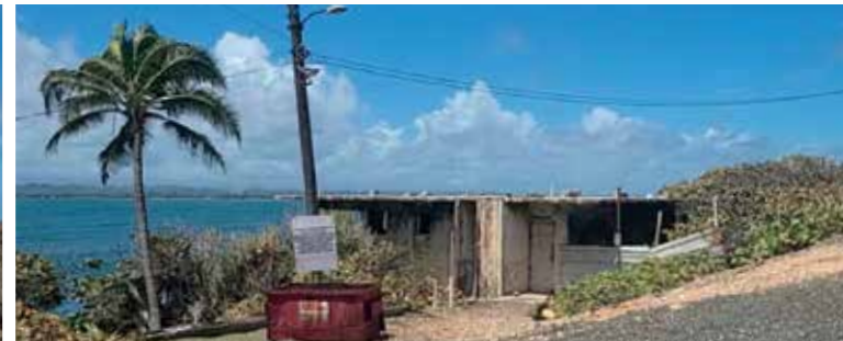
Figura 3.8 Antigua casa club (2022)
