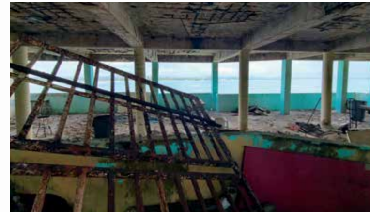
Figura 3.21 Acceso, Foto autor (2022)
