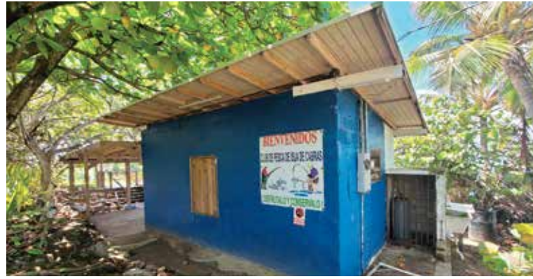
Figura 3.25 Casa club actual, Foto autor (2022)
