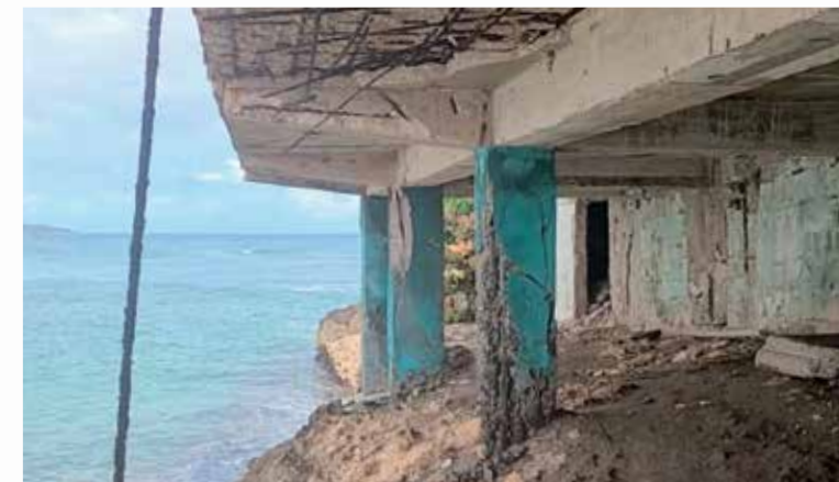
Figura 3.23 Estado de estructura, Foto autor (2022)
