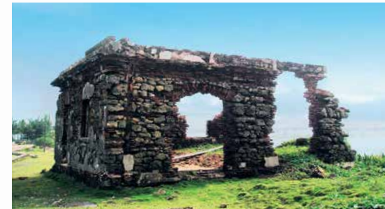
Figura 3.18 Antiguo Edificio de Administración, aprox.2011 Imagen tomada de (Schiappacasse, 2011)
