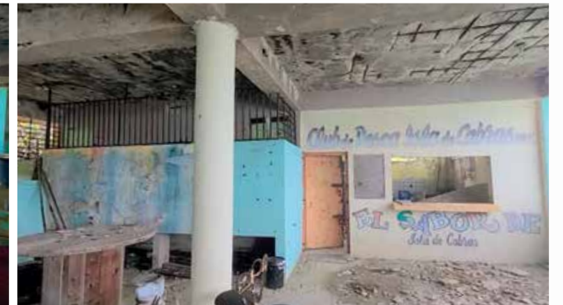
Figura 3.22 cocina y baños, Foto autor (2022)
