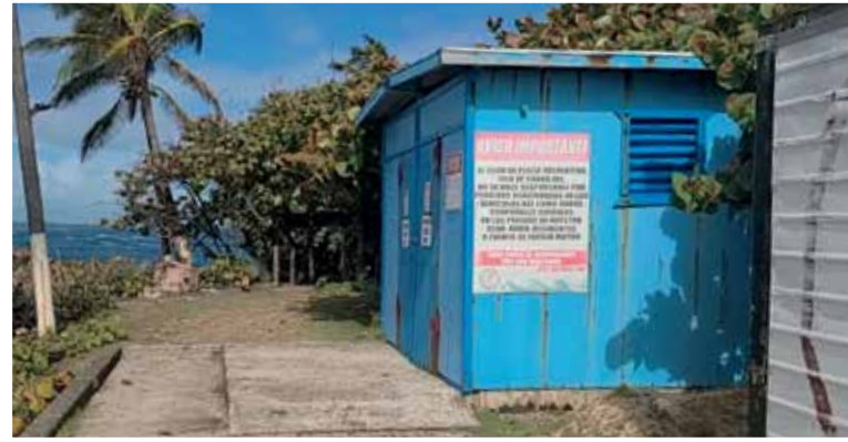
Figura 3.26 Baños y depósito "container", Foto autor (2022)
