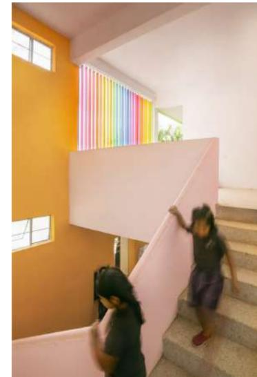
**Fachada perforada,** distribuida en diversas partes de la escuela, los quebrasoles verticales de colores son utilizados como elementos de transición entre el interior y el exterior, filtrando la luz natural y permitiendo la entrada de ventilación natural. El color es una característica particular de este proyecto, próximamente se explicará en detalle su propósito.
