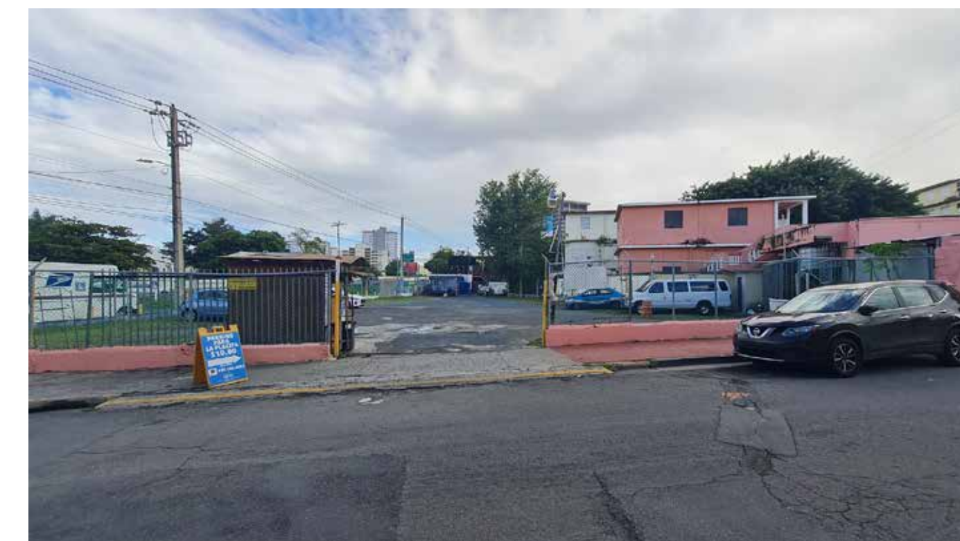
26 LA PLACITA fotografía sitio actual
