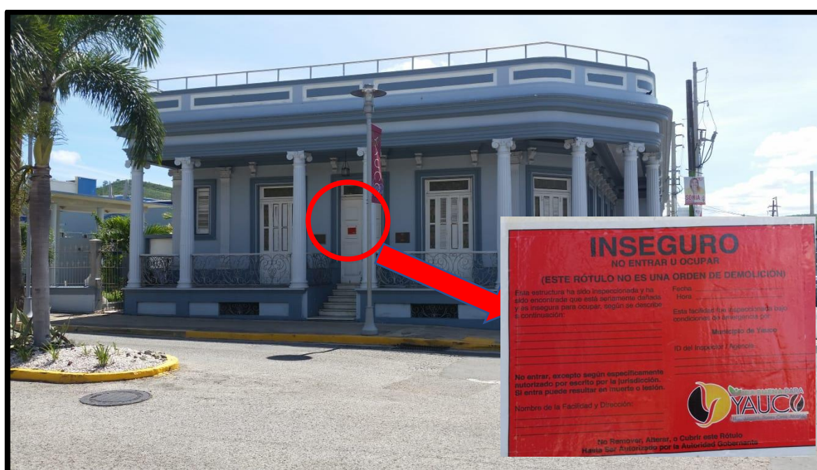
Imagen 33 La Casa Franceschi a Octubre del 2020. Se observa una rotulación en la puerta principal indicando su condición de inseguro y de no entrar u ocupar. Fuente: Archivo Fredy Caballero.
