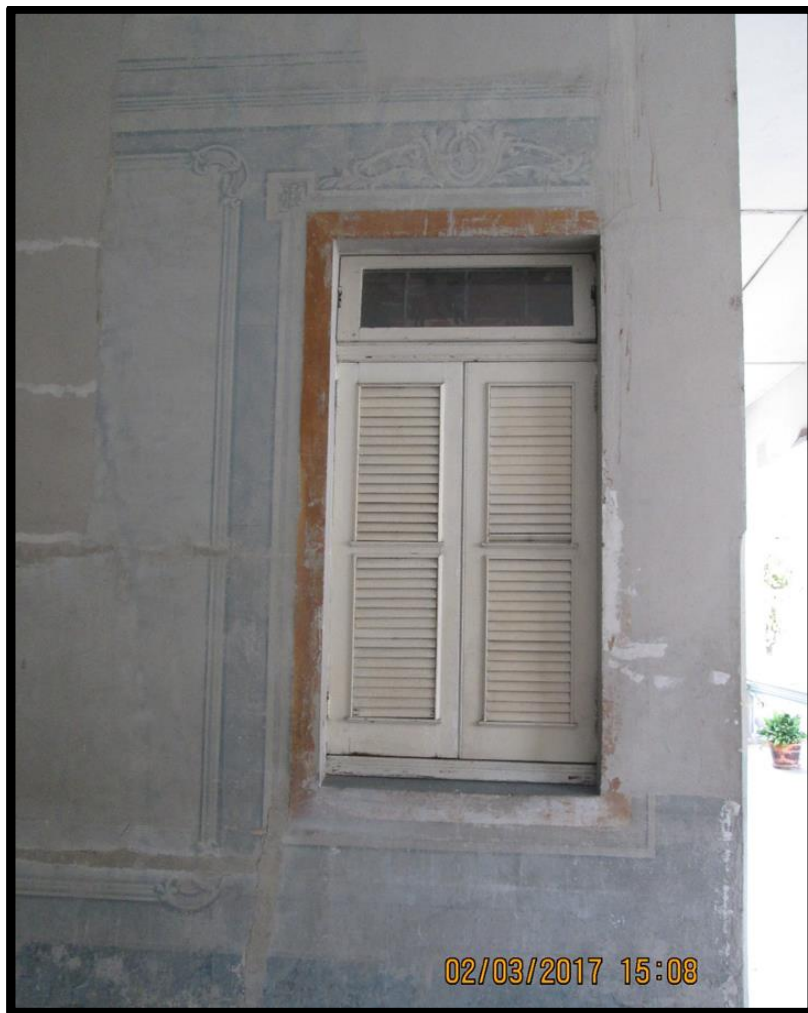
Imagen 25: Ventana de la parte externa de la casa. Se observan las pinturas murales alrededor de la ventana completamente ignoradas en las reparaciones. Fuente: Archivos Fredy Caballero.
