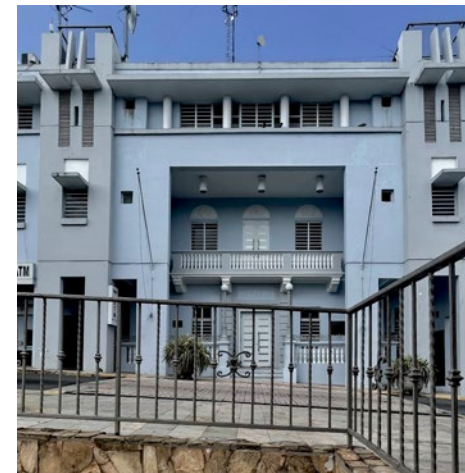
Edificio que posee rasgos híbridos. Imagen por la autora.
