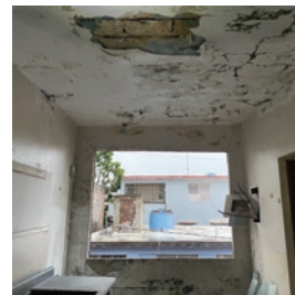
Condición interior del apartamento 5 3
