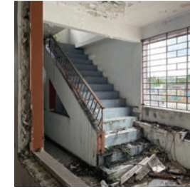
Escalera al techo 1
