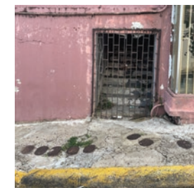
Contadores de agua frente a la entrada residencial en la fachada lateral
