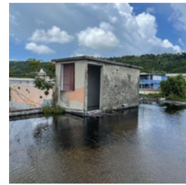
Acceso al techo 1
