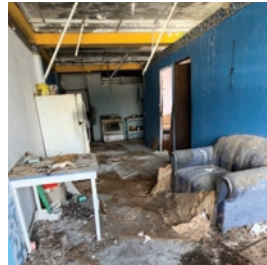
Condición interior del apartamento 1 5
